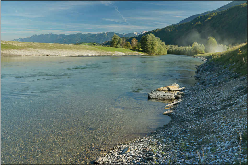
Abb. 21: Schotterböschungen innerhalb des Doppeltrapezprofils an der Unteren Gail im Feistritzer Moos (Kärnten). – Fig. 21: Gravel embankments within the double trapezoid profile on the Lower Gail in Feistritzer Moos (Carinthia). Foto/photo: C. Komposch, ÖKOTEAM.
